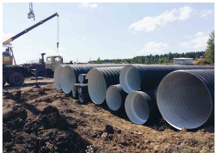
Объект: Технопарк «Отвель», Пензенская область, с. Кижеватово Подрядчик: ООО «РУСКОМПЛЕКТ»
