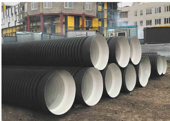
Объект: Реконструкция канализации, г. Белгород, ул. Есенина Подрядчик: ООО «Фланец-Комплект»
